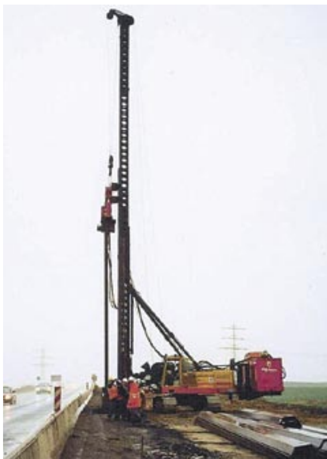
Fot. 2. Autostrada A4 odcinek Nogawczyce-Kleszczów Zastosowanie grodzic PU.16. Wykonawca AARSLEFF Sp. z o.o.
