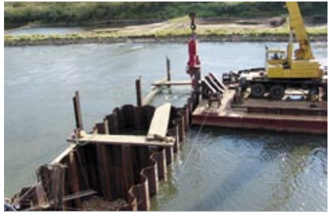
Fot. 4. Budowa progu wodnego na Wiśle w Połańcu. Zastosowanie grodzic AU 18 i AU 20. Wykonawca AARSLEFF Sp. z o.o.
