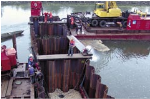
Fot. 3. Budowa progu wodnego na Wiśle w Połańcu. Zastosowanie grodzic AU 18 i AU 20. Wykonawca AARSLEFF Sp. z o.o.
